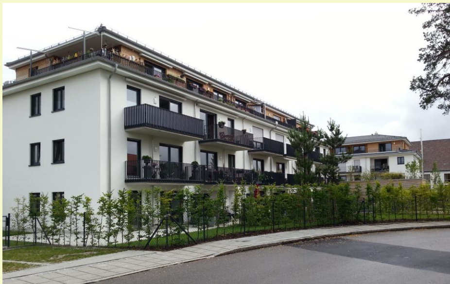
Foto: BayWa Energie Dienstleistungs GmbH
